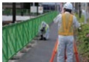
道水路設計の基礎となる中心点・IP点等を座標化し、縦断測量及び横断測量により地形データを取得、図面化するものであり、短期間で高精度な成果を提供し続けております。
