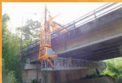
橋梁補修工事 設計業務委託 30-2
