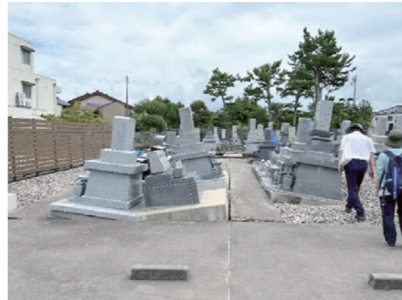
図-6 液状化被害(富山県氷見市)
