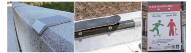
写真-4(左) スケートストッパーと呼ばれる抑制用の突起物 写真-5(中) 破損しやすい角を鉄製の縁材に改修の様子 写真-6(右) 禁止でなく滑走可能な時間を掲示するサイン (ボルドー市ホームページ)
