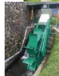
2017年11月水車設置完成
