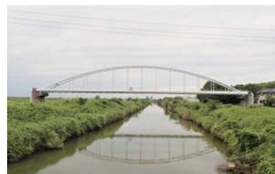
根木名川水管橋
