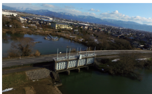
琵琶湖総管姉川・安曇川地区外水門等点検
