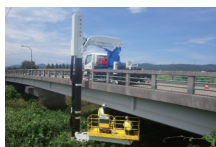
小矢部市橋梁詳細点検
