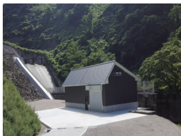
角川ダム小水力発電施設
