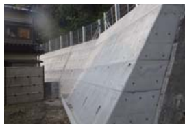
笠破地区急傾斜地崩壊防止施設長寿命化計画
