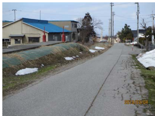
⑤暗渠部・・・暗渠内に落差工（落差不明）
