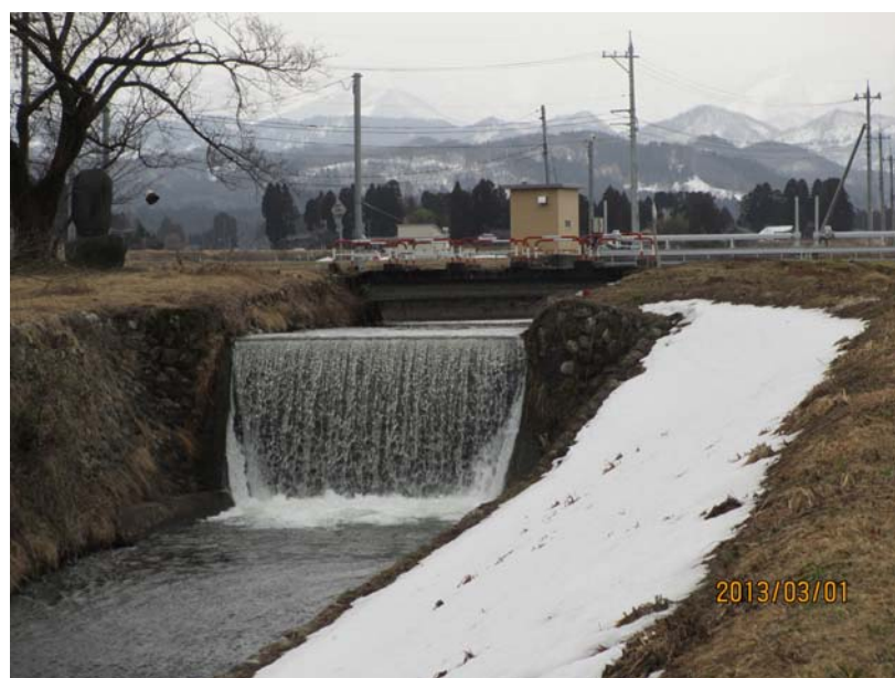
図Ⅱ－6（２） 仁右衛門分水下流の落差工（落差約 2.4m）の写真
