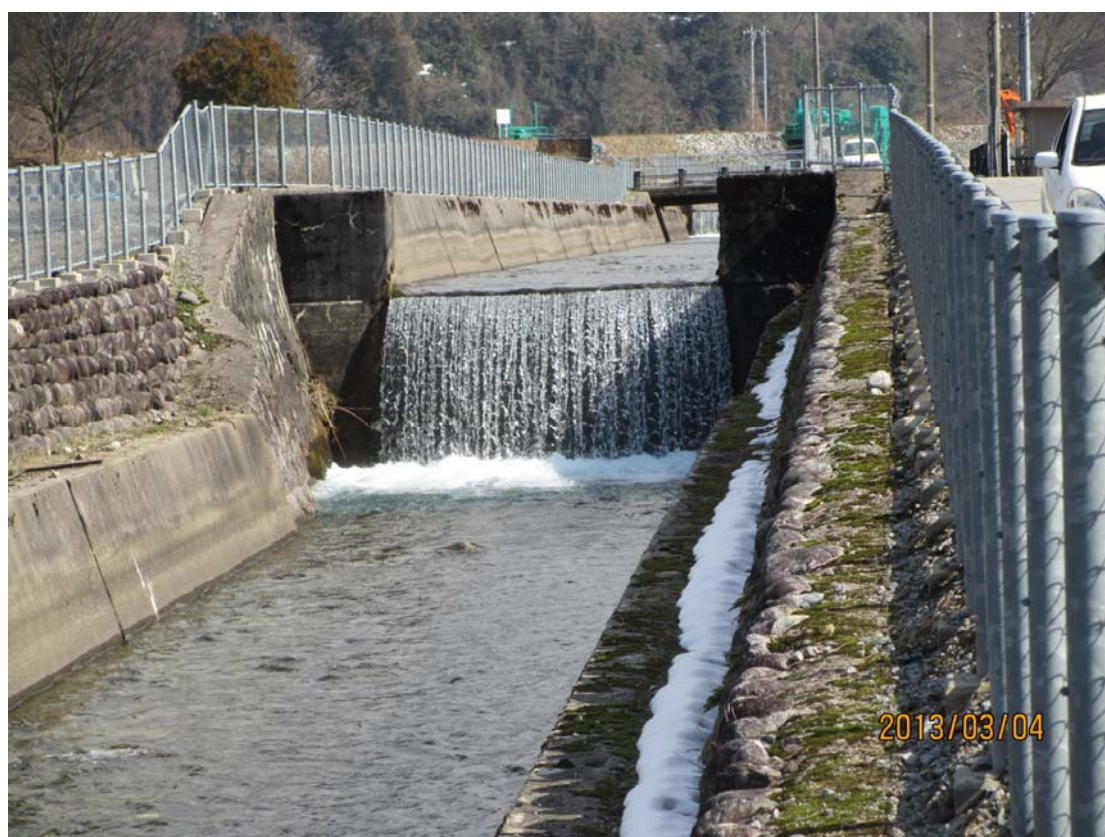
図Ⅱ－７（２） 導水路二区終点の落差工（落差約 1.9m）の写真
