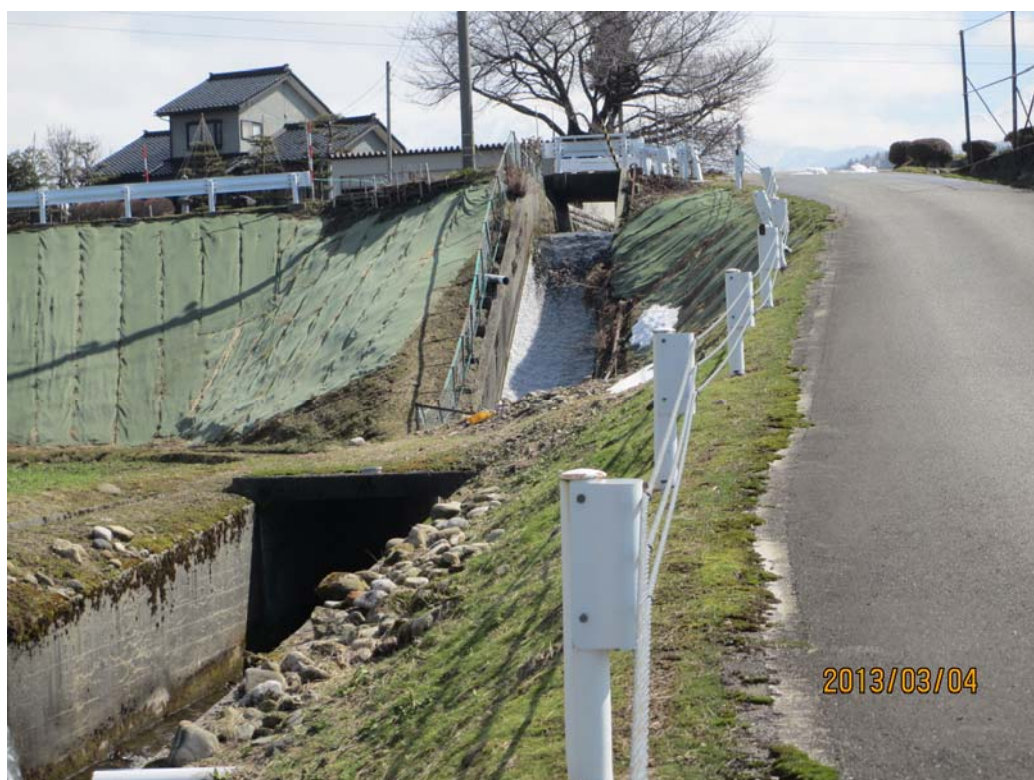
図Ⅱ－3（２） 荒井排水路急流工（落差約5.7m）の写真
