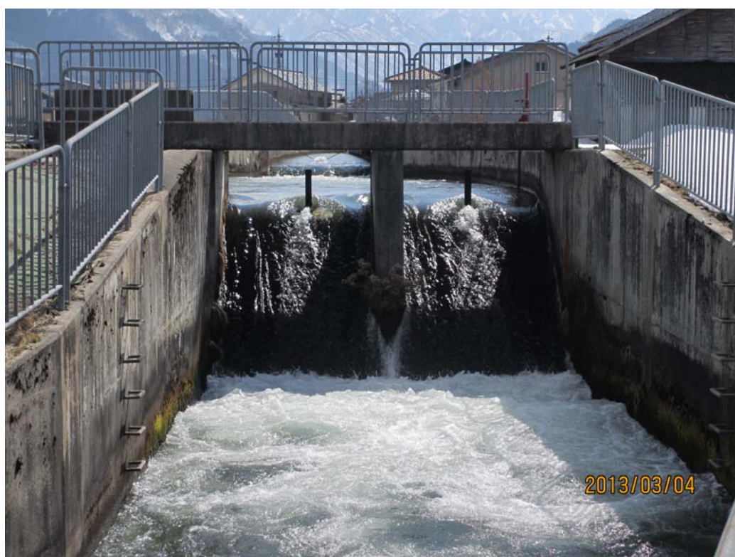
図Ⅱ－４（２） 分水工（落差約 1.5m）の写真
