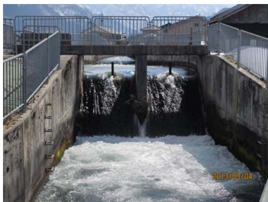
①分水工（落差約 1.5m）
