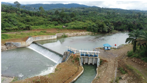
取水堰・取水口
