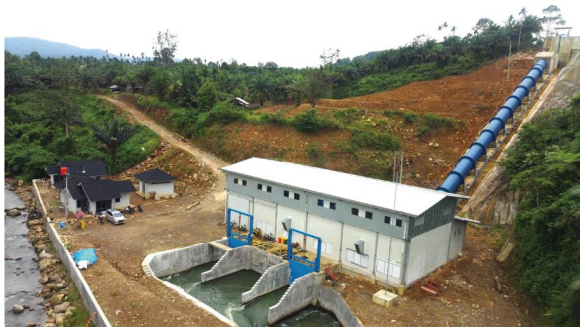
発電所建屋全景
