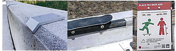
写真-4(左) スケートストッパーと呼ばれる抑制用の突起物 写真-5(中) 破損しやすい角を鉄製の縁材に改修の様子 写真-6(右) 禁止ではなく滑走可能な時間を掲示するサイン※2
