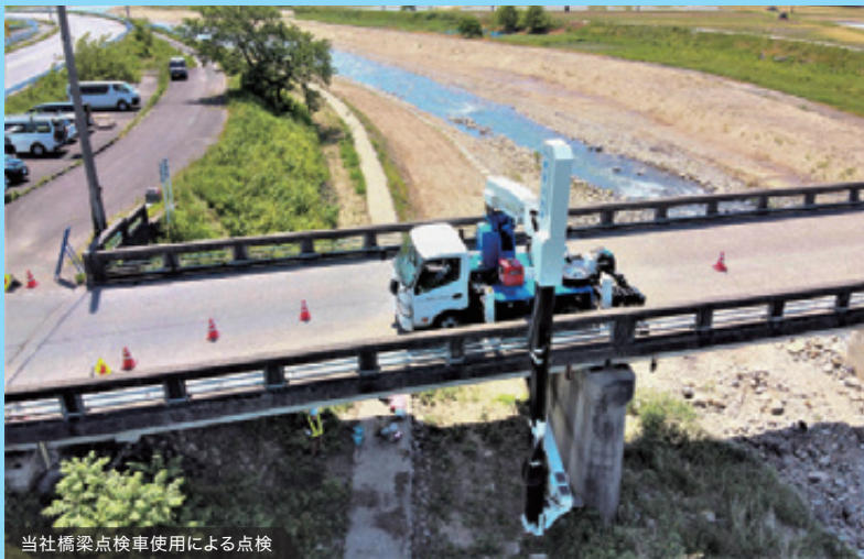
当社橋梁点検車使用による点検
