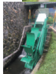
2017年11月水車設置完成
