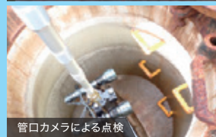
管口カメラによる点検
