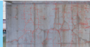
写真技術を用いた点検調査(当社保有 UAV)
