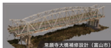
常願寺大橋補修設計（富山市）
