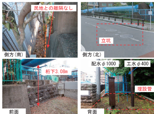
図-7 B橋 周辺支障物
