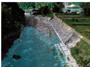
図-10 支川河岸浸食
