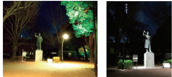
【整備前】 投光器(写真右手前)により加光されているがぼんやりとした印象 【整備後】 適切な光色・照射角で像に陰影が付き印象的な演出になった
