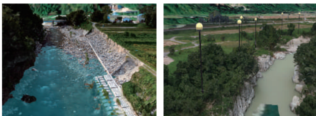
図-10 支川河岸浸食
