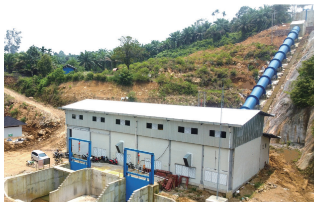
トンガル発電所 外観
