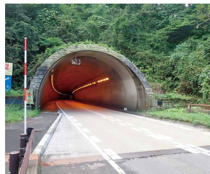
新大沼トンネル(北海道)
