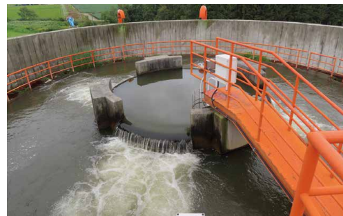
石狩川上流地域 国営造成水利施設機能診断調査検討業務(北海道)
