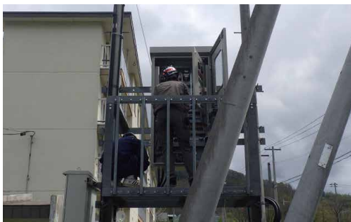
夕張市 公共下水道ストックマネジメント計画策定(北海道)
