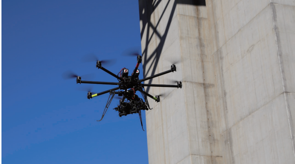
写真技術を応用した点検調査
