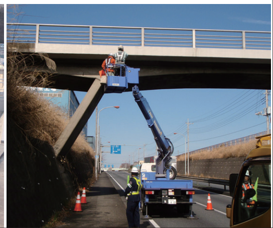
橋梁点検(花ヶ谷戸橋)
