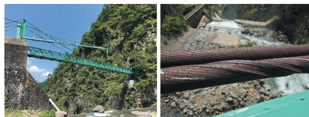
写真-1 現況状況
