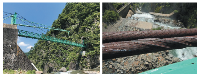
写真-1 現況状況
