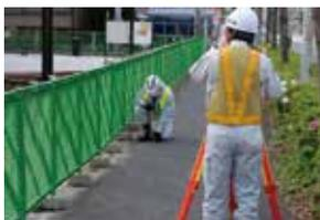
道水路設計の基礎となる中心点・IP点等を座標化し、縦断測量及び横断測量により地形データを取得、図面化するものであり、短期間で高精度な成果を提供し続けております。
