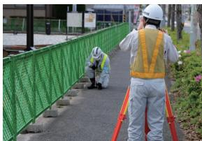
道水路設計の基礎となる中心点・IP点等を座標化し、縦断測量及び横断測量により地形データを得、図面化するものであり、短期間で高精度な成果を提供し続けております。
