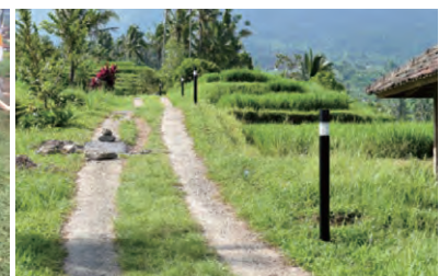
設置した街灯
