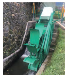
2017年11月水車設置完成
