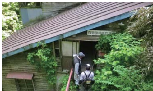
旧金沢白雲楼河内発電所建屋外観
