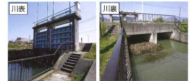
写真-2 施設状況写真
