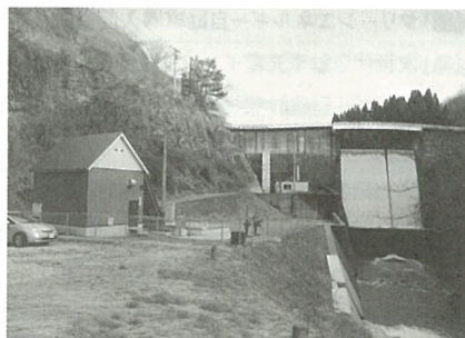
平沢川小水力発電所
