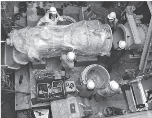
写真-5 水車据付状況
