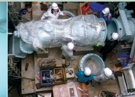
写真6 水車据付状況
