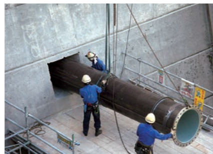
写真1 取水管挿入状況
