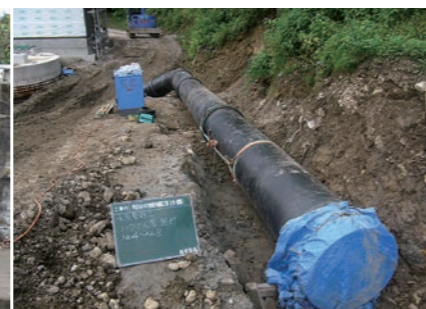
写真4 埋設管（ハウエル管）据付状況
