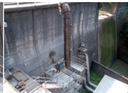
写真2 導水管（鋼管）据付状況
