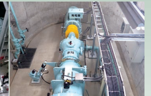
写真7 水車発電機据付完了
