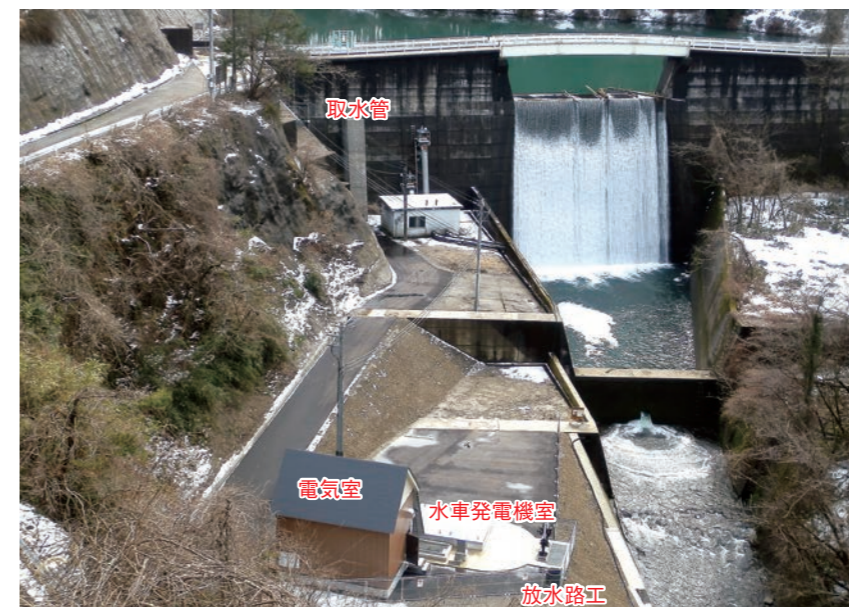
写真8 平沢川小水力発電所全景
