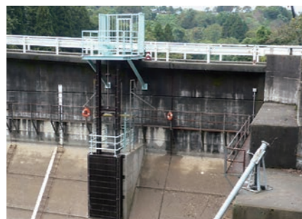
写真3 取水口ゲート据付完了
