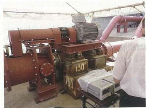
写真-2 試作水車(40kW)による特性試験
