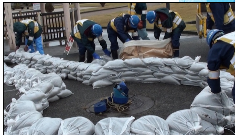
緊急措置訓練（仮排水路設置）
