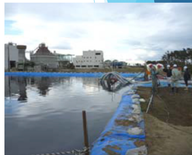
簡易沈殿池の例
