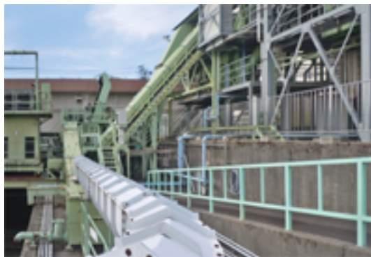
下水道ポンプ場
