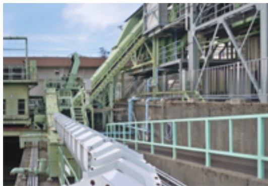
下水道ポンプ場
