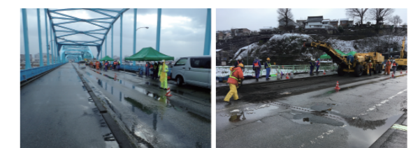
実施状況(神通大橋)
