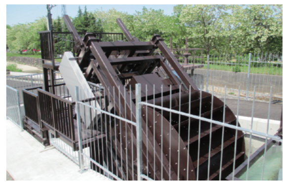
西番小水力発電所
