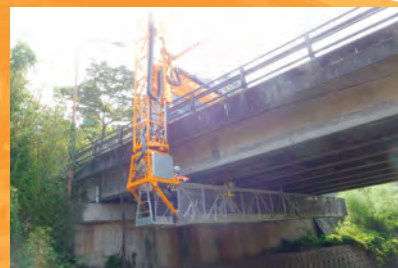
橋梁補修工事 設計業務委託 30-2
