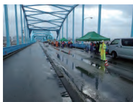
実施状況(神通大橋)
