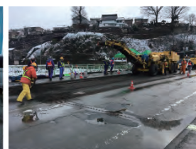
舗装開削による答え合わせ (八尾大橋)
