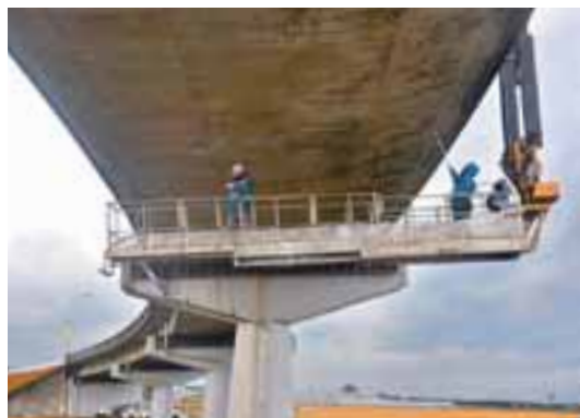
橋梁点検車で橋梁の裏面や橋脚に接近して目視点検
