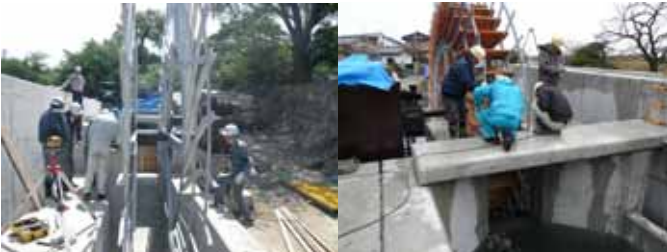
写真-1 水車据付
