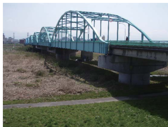
写真-1 神通大橋(下流側)全景写真
