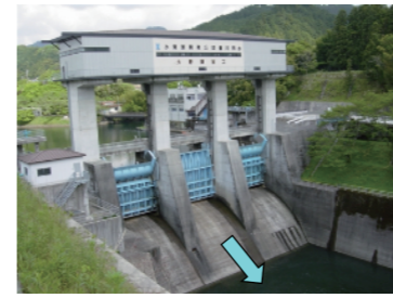
写真-1 大野頭首工(右岸下流から望む)
