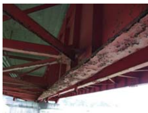
写真-2 塩化物イオン付着鋼桁
