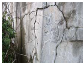
写真-3 ASRによる損傷例
