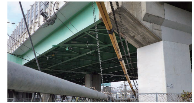
図-15 特別高压架線状況
