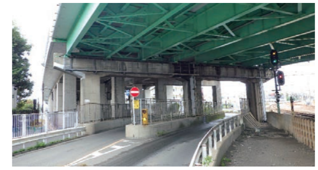
図-16 終点側橋脚周辺状況
