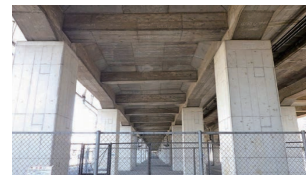
図-5 橋脚柱RC巻立て状況
