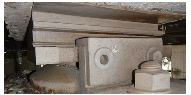
図-11 既設支承(線支承)
