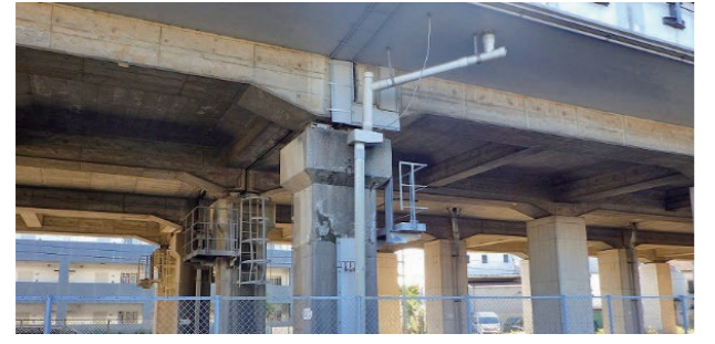
図-10 端支点橋脚柱
