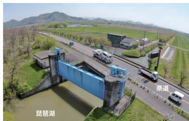
写真-1 堤防天端利用状況
