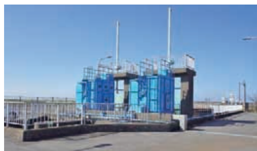
写真-1 笹川取水工(全景)
