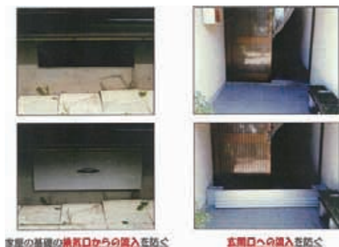
写真-2 床下進入水防止板
