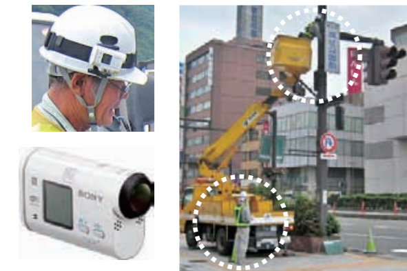
図-4 ヘルメットカメラ導入による点検状況
