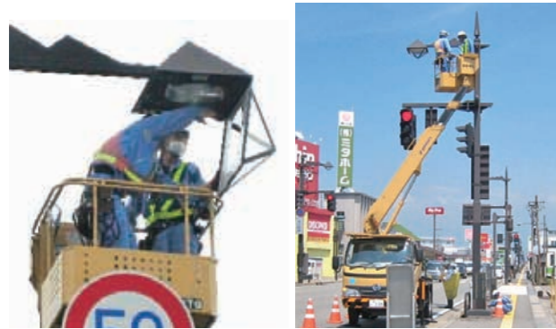
図-3 通常の点検状況
