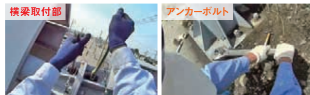
図-5 点検状況写真
