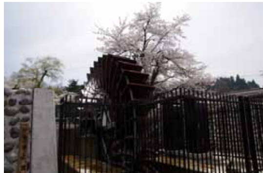
写真-4 発電所完成
