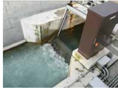
写真-3 流量調整ゲート
