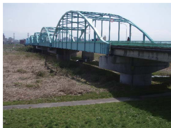
写真-1 神通大橋(下流側)全景写真
