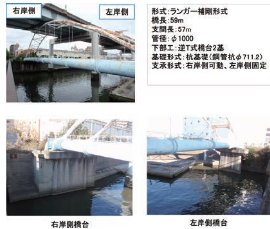
写真-2 水管橋現況
