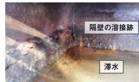
写真-2 鋼製地覆内部
