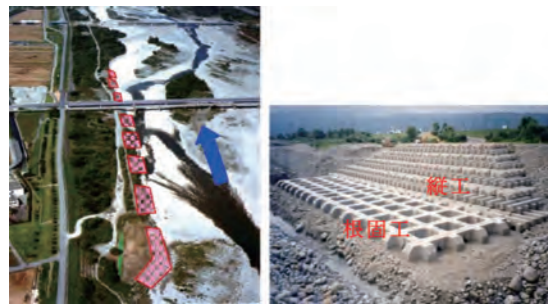
図-1 縦工の整備 1)
