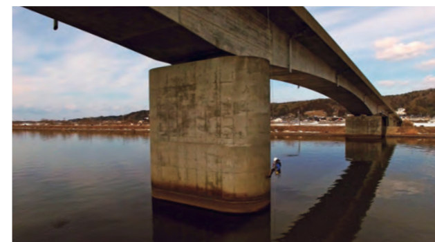
写真-4 特殊高所技術による点検状況
