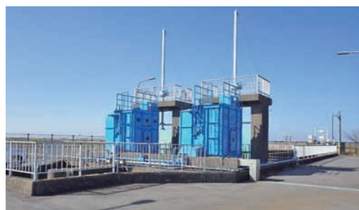
写真-1 笹川取水工(全景)
